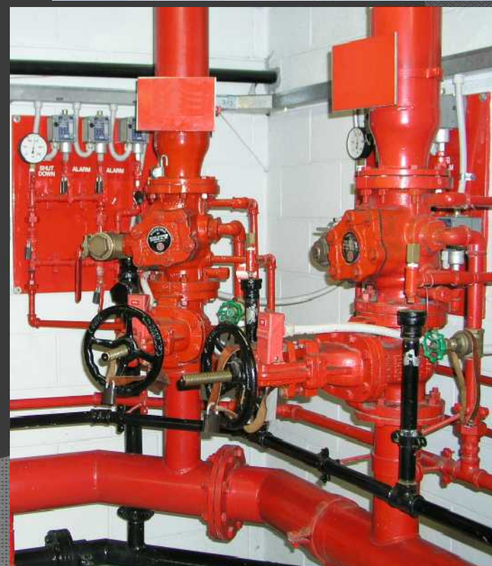
ESEMPIO DI STAZIONE DI COMANDO E CONTROLLO
